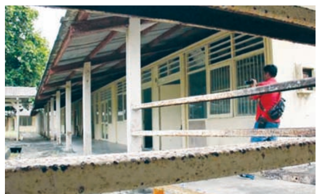
SEGERA DIRENOVASI: Gedung bekas rumah sakit di Kamp Vietnam, Pulau Galang, Batam. Gedung akan digunakan rumah sakit rujukan.
