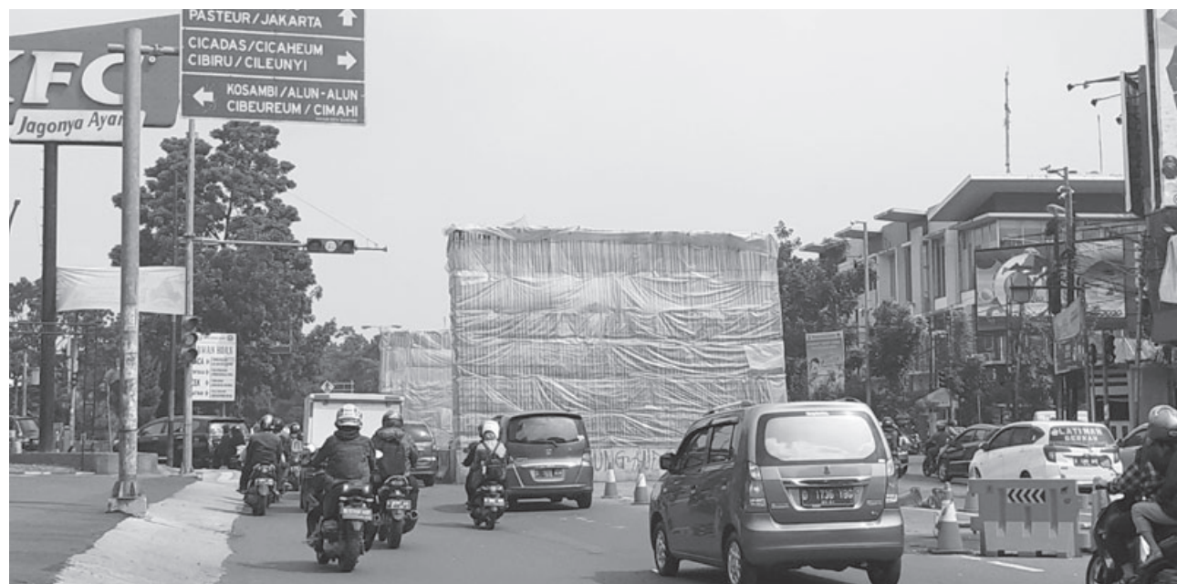
TUNGGU LELANG: Saat ini baru berdiri pilar-pilar dan pondasi untuk pembangunan flyover di Jalan Jakarta-Supratman. Rencananya proyek pembangunana akan segera dikerjakan kembali pada tahun ini setelah proses lelang selesai dilakukan.
