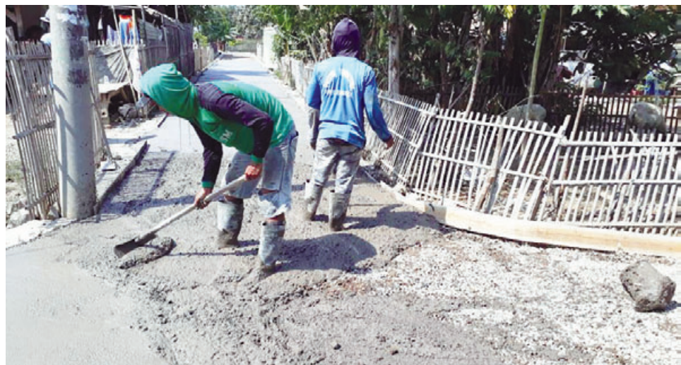
ILUSTRASI: BANGUN INFRASTRUKTUR: Sejumlah masyarakat bergotong-royong membangun jalan. Pembangunan ini bersumber dari dana desa untuk mendongkrak ekonomi warga.
