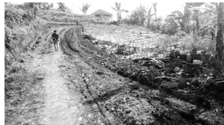
DIHENTIKAN: Pembangunan jalan poros tengah yang menghubungkan Kecamatan Cilawu-Banjarwangi dihentikan Pemkab Garut.
