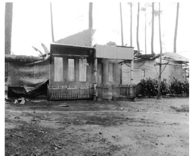
ALAMI KERUSAKAN: Sebuah rumah tertimpa pohon lantaran sudah rapuh serta terbawa angin di musim hujan.
