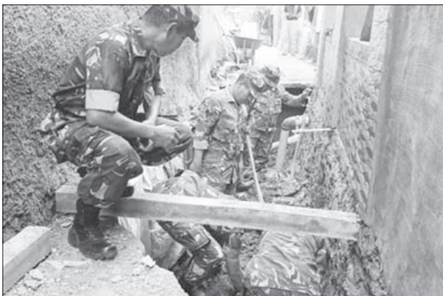
GOTONG ROYONG: Sejumlah anggota Danramil 1005 Kecamatan Jatininggal memasang gorong-gorong untuk mencegah banjir.
