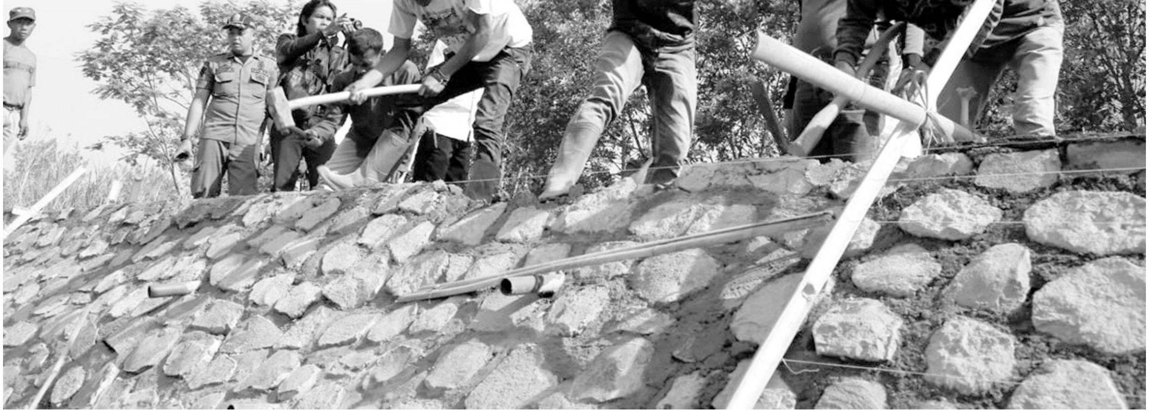
PANTAU PEKERJA: Bupati Bandung Barat, Aa Umbara Sutisna saat mengecek para pegawai mengerjakan proyek kirmir di sekitar Perkantoran Pemkab Bandung Barat belum lama ini.
