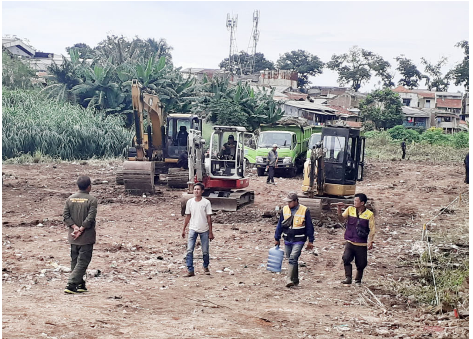
MULAI DIBANGUN: Pembanguna kolam retensi, mulai dilakukan. Penambahan kolam retensi tersebut bertujuan untuk meminimalisir banjir yang kerap terjadi di Jalan Pagarsih.
