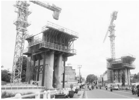
PROSES PEMBANGUNAN: Para pekerja tampak sedang menyelesaikan proyek KCJB di Jalan Raya Gadobangkong KBB, kemarin.
