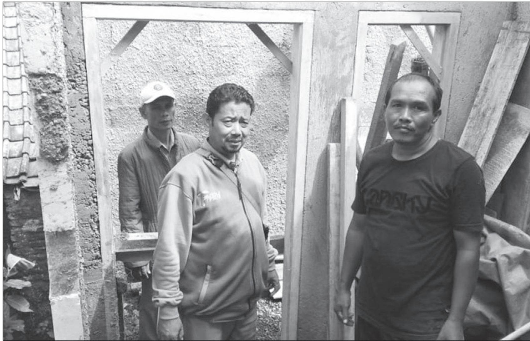
PENINJAUAN: Lurah Sriwidari, Didin Rosidin saat meninjau pembangunan rutilahu yang sudah mencapai 60 persen, Selasa (21/1).
