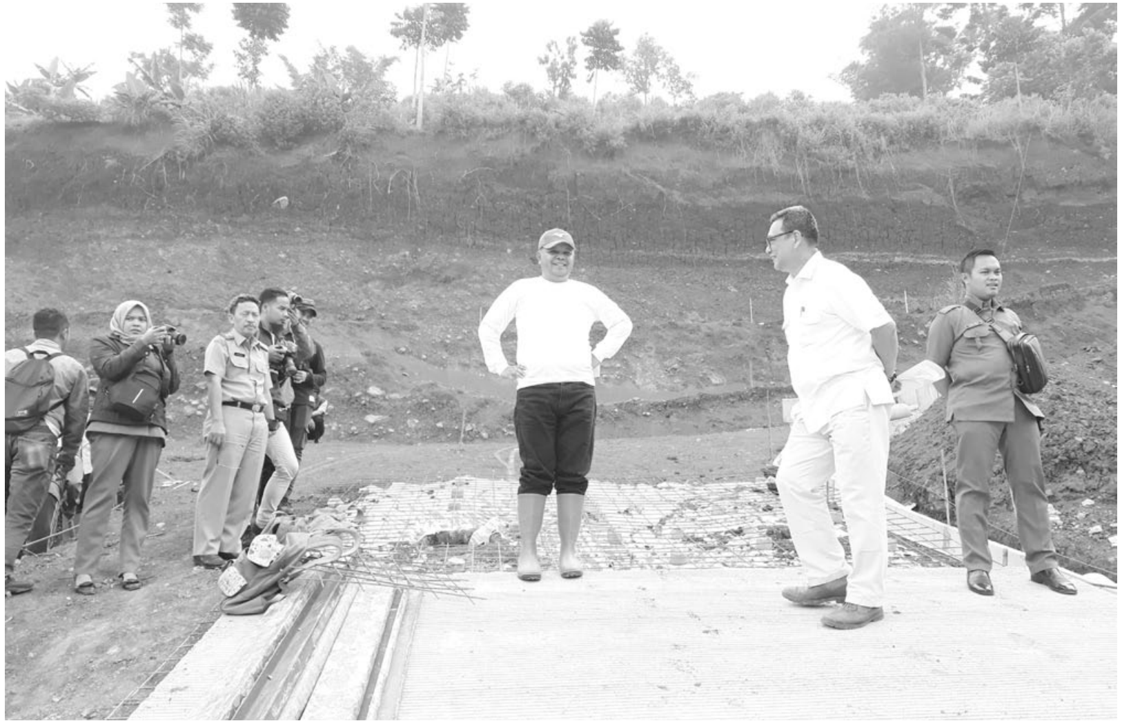
TINJAU PEMBANGUNAN: Bupati Bandung Barat, Aa Umbara Sutisna meninjau lokasi perumahan Pramestha Resort Town yang berlokasi di Desa Langensari, Lembang, Selasa (21/1).
