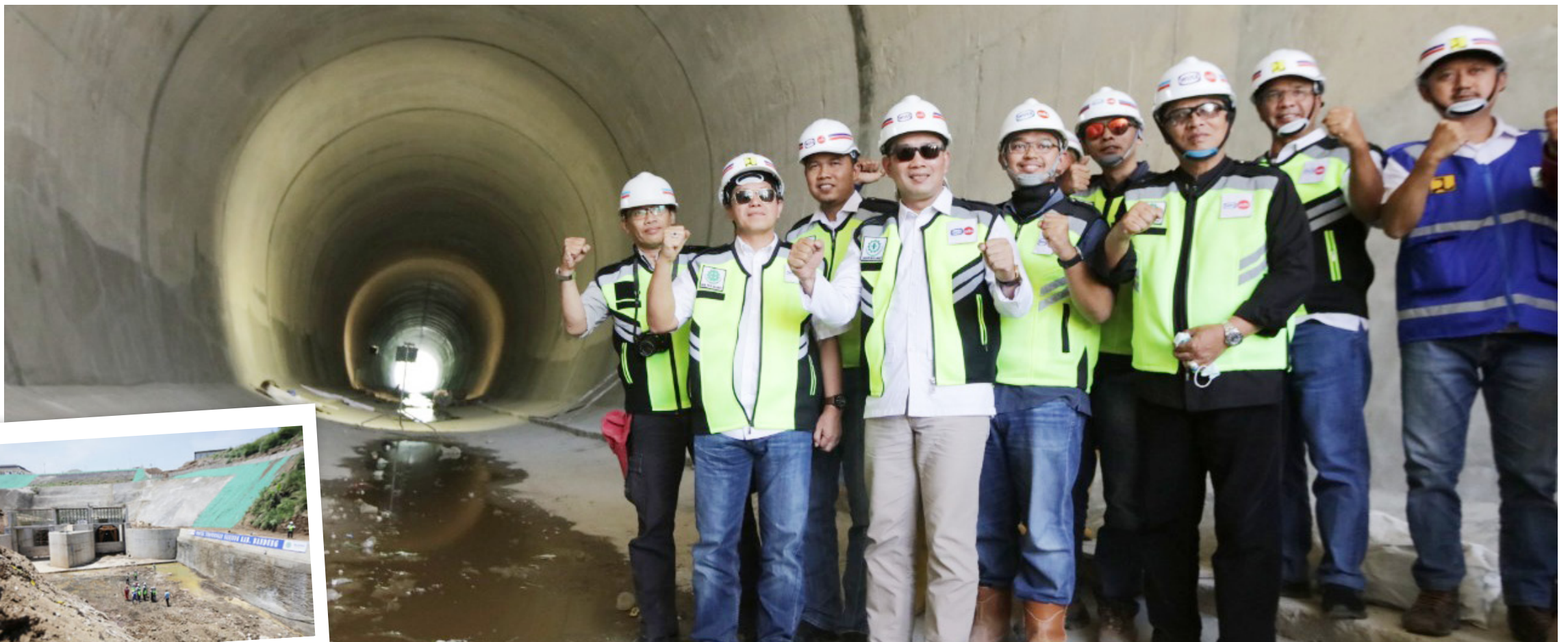
Peninjauan Terowongan Nanjung saat masih tahap pengerjaan, Sabtu (16/11/2019).
