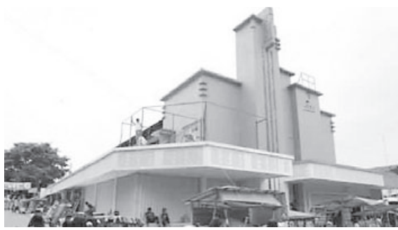
BANGUNAN BERSEJARAH: Gedung Rio merupakan bangunan heritage yang sudah ada sejak zaman Belanda. Saat ini gedung bekas bioskop tersebut digunakan untuk jual beli gadget.
