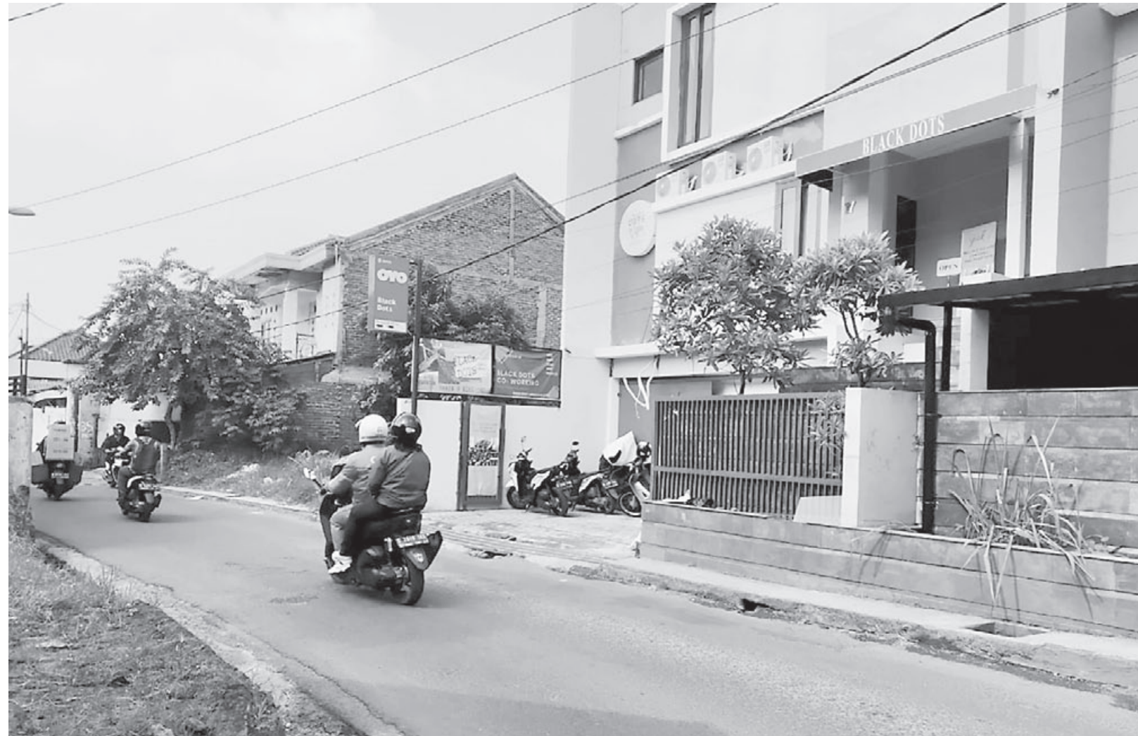
WARGA TERGANGGU: Warga RW 07 Kelurahan Pasirkaliki resah dengan keberadaan bangunan yang tiba-tiba dijadikan hotel. Pasalnya keberadaan hotel berlokasi di tengah permukiman warga.
